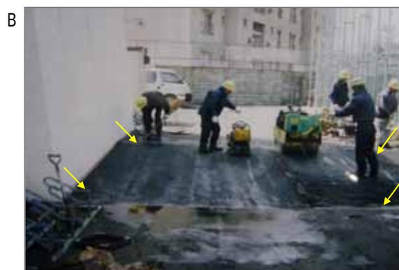
舗装工事、割栗石、砂利、アスファルト(瀝青ともいいます)の順で平らな固い地面を作ります(ローラーにて転圧)。
