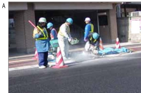
道路工事、補修作業時には粉じんが発生します。アスファルトにかつて石綿が混入していた区間においては、石綿粉じんばく露する可能性があります。
