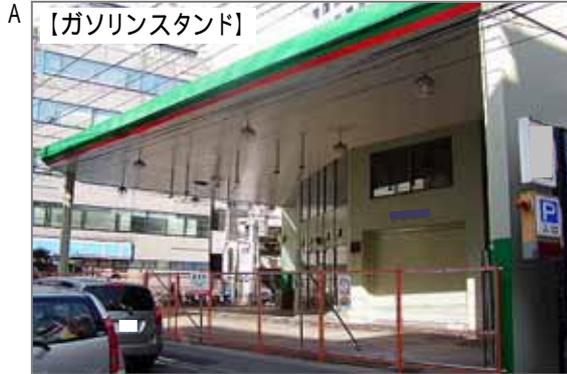
【概要】防火地域にあって昭和63年以前に建設された給油所では、建屋やキャノピーの鉄骨等に吹きつけ石綿が使用されている場合があります。また、建屋の壁・床は石綿1%含有ボードを使用している場合があります。
