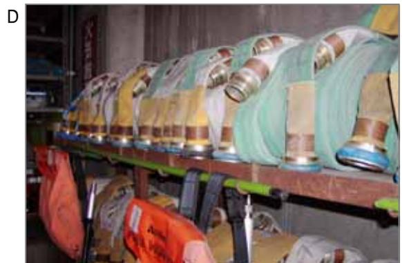
ホースも高圧の水力には破れないように金線や石綿が入っているものもありました。同じくビル内の廊下の壁などに収納されている消火栓箱も裏面などは耐火構造になっています。これらの石綿含有の耐火製品や耐火物が劣化・損傷等することにより、飛散した石綿にはばく露する可能性があります。
