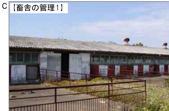
【概要】多くの家畜舎は安くて長持ちするスレート屋根・壁で出来ています。中には糞尿による床の腐食防止のために、床にも石綿セメント板を使って絶対腐らない、ダニなどが発生しない衛生的な畜舎もあります。糞尿の清掃時に床をこすることによって、石綿が飛散した可能性があります。
