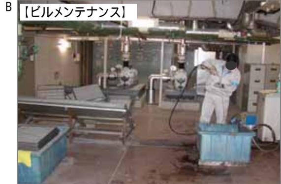
【概要】ビルメンテナンス業。古くて大きなビルでは空調(エアコン)のフィルターを定期的に洗っています。フィルターには全ての微粉じんが混ざっていると考えられ、洗浄時にばく露する可能性があります。
