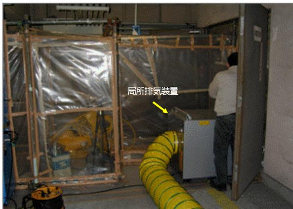
ビニールの中の吹きつけ石綿除去部から、排気を行い除去部を負圧（陰圧）に保つ局所排気装置が、右下の銀色の装置です。局所排気装置の中には、石綿を除去し外気にださないようにする HEPA フィルターが装着されています。局所排気装置を通過した排気が通る部分が、黄色のじゃばら管です。
