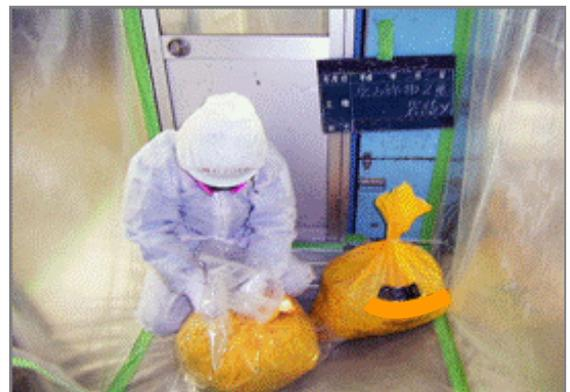
除去した石綿は破れないように厚手のビニール袋（石綿であることを明示）に二重に入れます。石綿粉じんの環境測定も適時行います。
