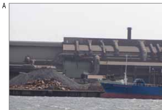
【概要】製鉄は非常に熱エネルギーを必要とする産業で、多量の断熱材などが使用されています。コークス炉をはじめ、暑い(熱い)ところや粉じんの発生が多い作業環境です。
