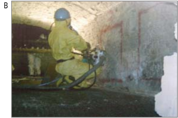
写真は焼却炉内の石綿含有不定形耐火物のクリンカ(すず等付着物)除去作業です。クリンカ除去時に耐火物の一部を破損し、石綿粉じんが発生する可能性があります。
