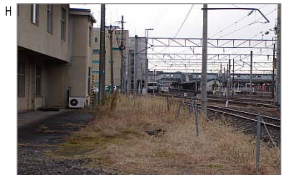
駅のそばにある信号詰め所では操車係や乗務員が休憩します。建物に、吹きつけ石綿が使用されていた場合、劣化や破損によってばく露した可能性があります。
