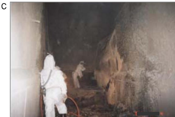
同上、炉内でのクリンカ除去作業。表面を除洗したり、ワイヤーブラッシングしたりします。この他に古いパッキングの交換や保温材の撤去、更新などの石綿取扱い作業を行います。
