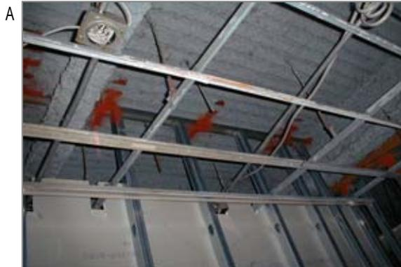
A 吹きつけ石綿のある建物の工事例で電気・衛生・建築業者が作業しました。吹きつけ石綿が除去され赤い鉄骨が見えますが、作業をした際に石綿にばく露した可能性があります。
