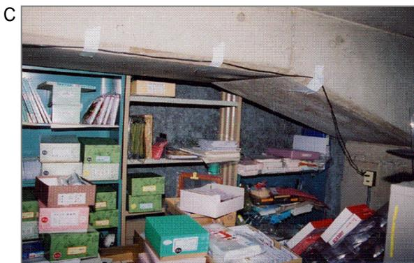
倉庫の壁に青石綿が吹き付けられていますが、経年劣化しており、飛散しやすい状況でした。この倉庫に、業務のために毎日数回出入りをされていた方が中皮腫を発症されました。
