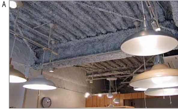
店舗、ヘヤーサロン、ゲームセンター等の耐火被覆の露出天井。石綿含有吹きつけの場合、劣化や損傷により石綿繊維が飛散し、このような環境で労働をした従業員が長期にわたってばく露をする可能性があります。
