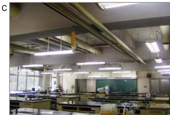
C 学校の実験室の天井に吹きつけ石綿があります。パーナーやアルコールランプなど火を使うため、耐火・結露防止目的と考えられます。一部、大きく脱落している箇所があり、露出した破損部から飛散した石綿に、教員が長期にわたってばく露した可能性があります。
