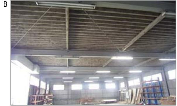
ある工業部品の倉庫の屋根、梁(はり)に石綿が吹きつけられています。倉庫の荷物の出し入れの際に壁を損傷したり、自然劣化等により、石綿が飛散し作業員がばく露する可能性があります。
