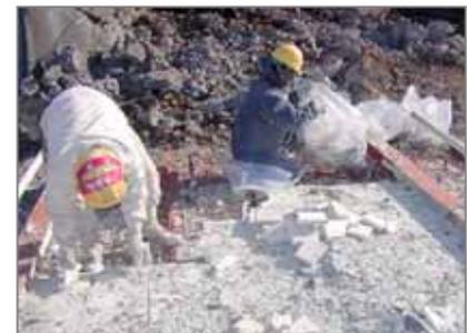
炉の保温材の撤去、回収作業
